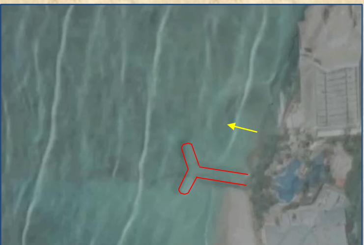
Rock T-head groin
