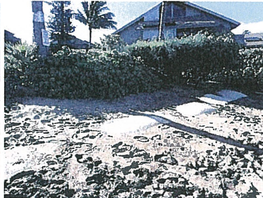
WP308 Exposed geotextile bags Latitude 20.97619N Longitude 156.67805W
