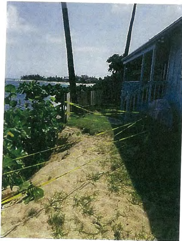
Erosion Control – 59-175 B Ke Nui Rd. – 59-175 C Ke Nui Rd.
