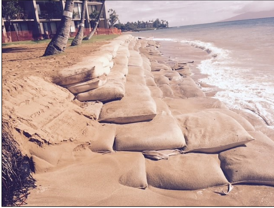
Figure 3-6 Geotextile sandbag revetment (Kahana, Maui, Hawaii)
