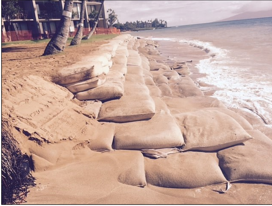
Figure 3-6 Geotextile sandbag revetment (Kahana, Maui, Hawaii)
